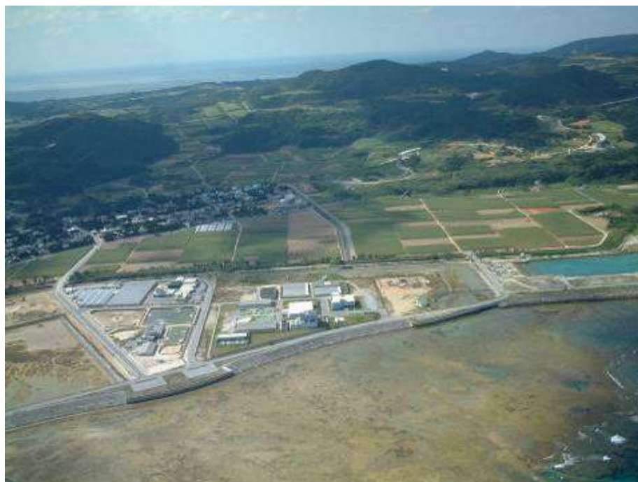
図表 1-2 沖縄県海洋深層水研究所および周辺立地施設
